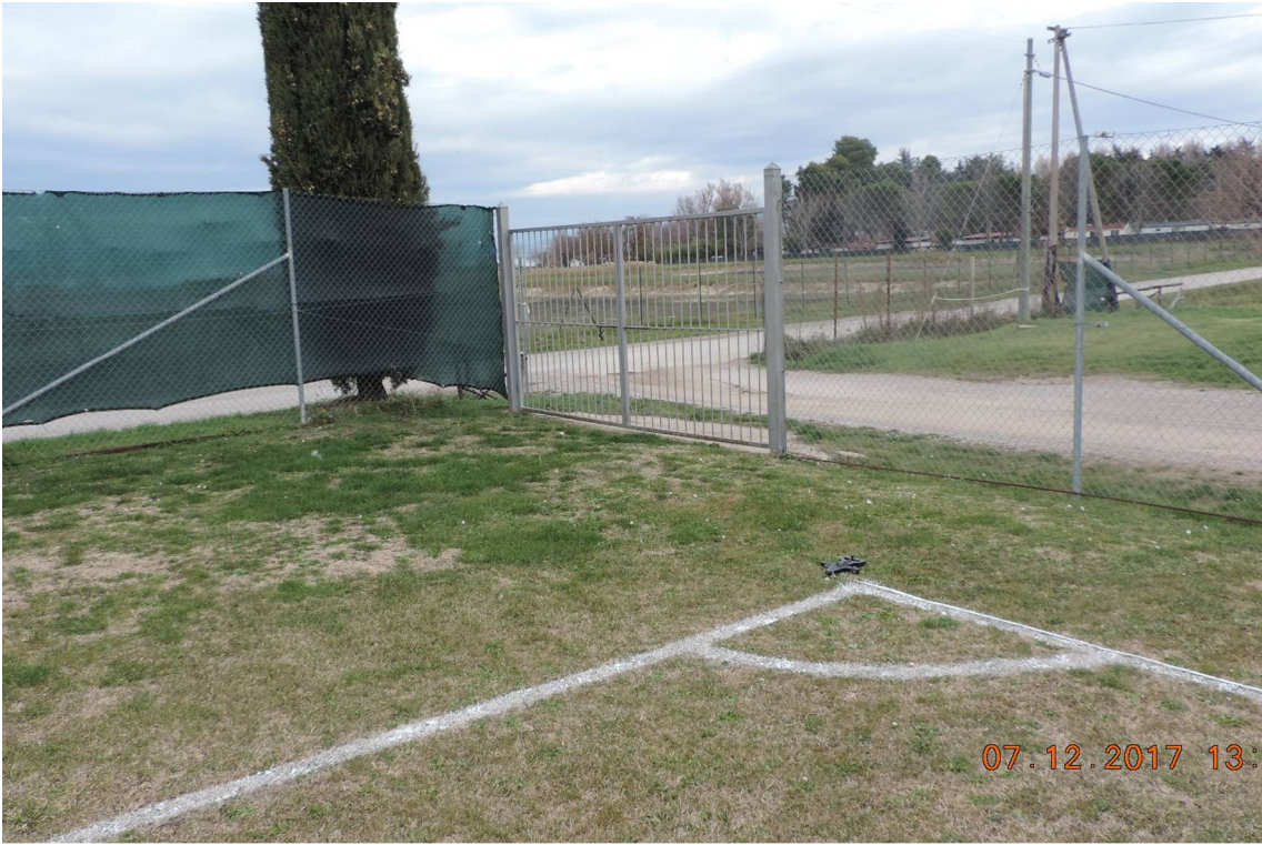
Cancello ingresso mezzi di soccorso
